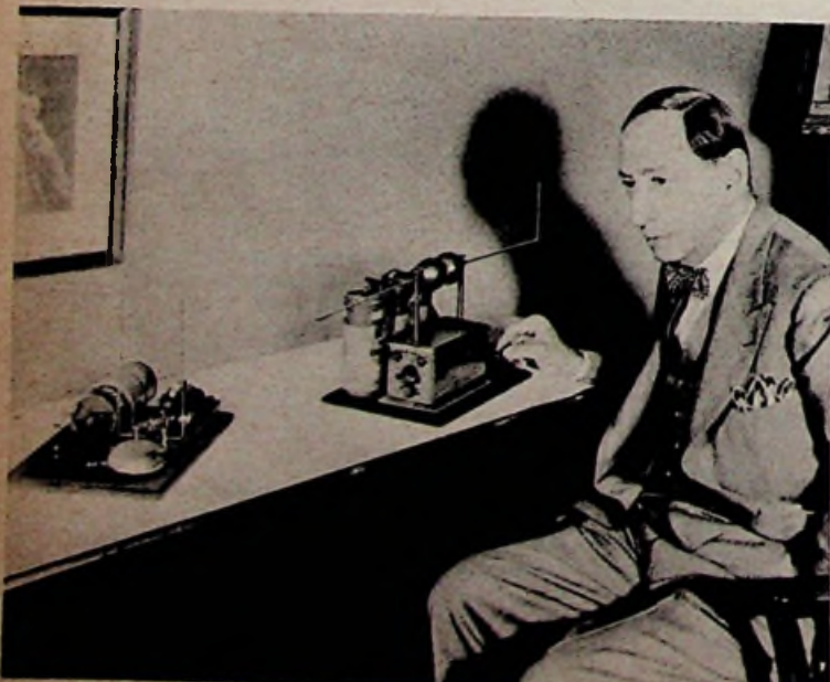
Bild 1. Nachbauten der 1905 von Hugo Gernsback, New York, entwickelten Kleinfunkstation. Links Empfänger mit Relais, Kohärer und Klingel, rechts Funkenstreckensender für \lambda \sim 10 m. An den Geräten: Hugo Gernsback
